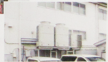
▼一体空冷式インバータコンデンシングユニットは1階外壁に設置。海が近いので全て対塩害仕様を採用
