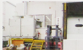
▼一体空冷式インバータコンデンシングユニットは1階外壁に設置。海が近いので全て対塩害仕様を採用
